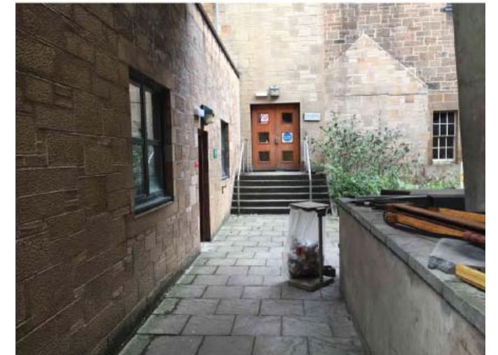
4. Fire escape door from Lecture Theatre 257 (Entrance Door 5)
